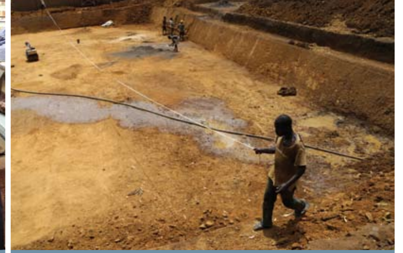
I lavori di scavo di una delle nuove lagune per le acque reflue
