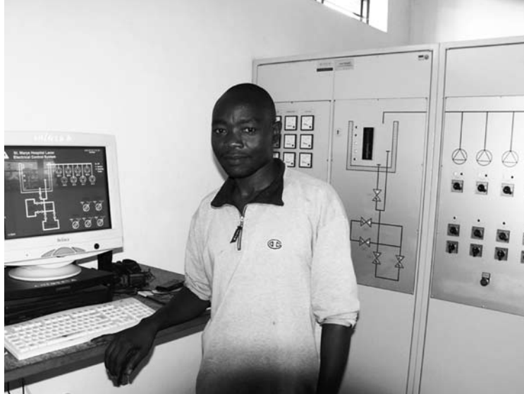
Santo Uma nella sala di controllo dei sistemi elettrici e idrici
